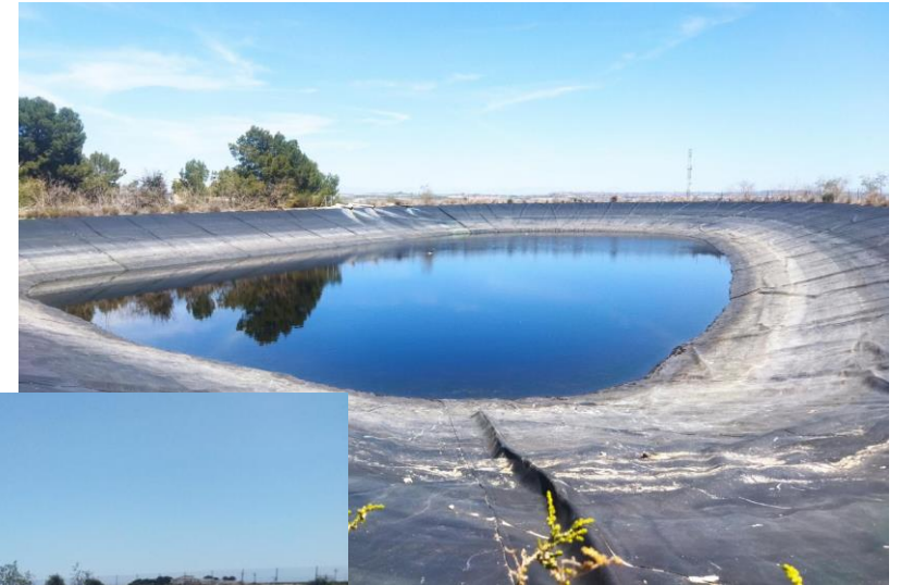
Figura 3. Balsa de riego de PVC (arriba) y balsa de riego de grava (izquierda). Proporción de balsas según material de construcción.
