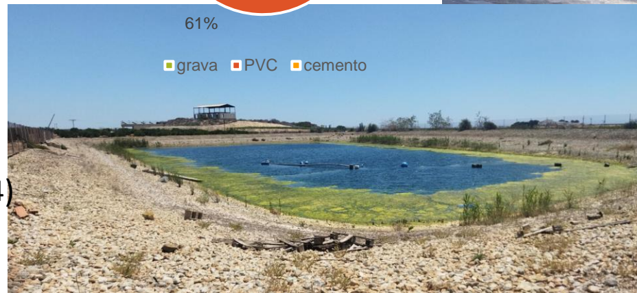
Figura 3. Balsa de riego de PVC (arriba) y balsa de riego de grava (izquierda). Proporción de balsas según material de construcción.
