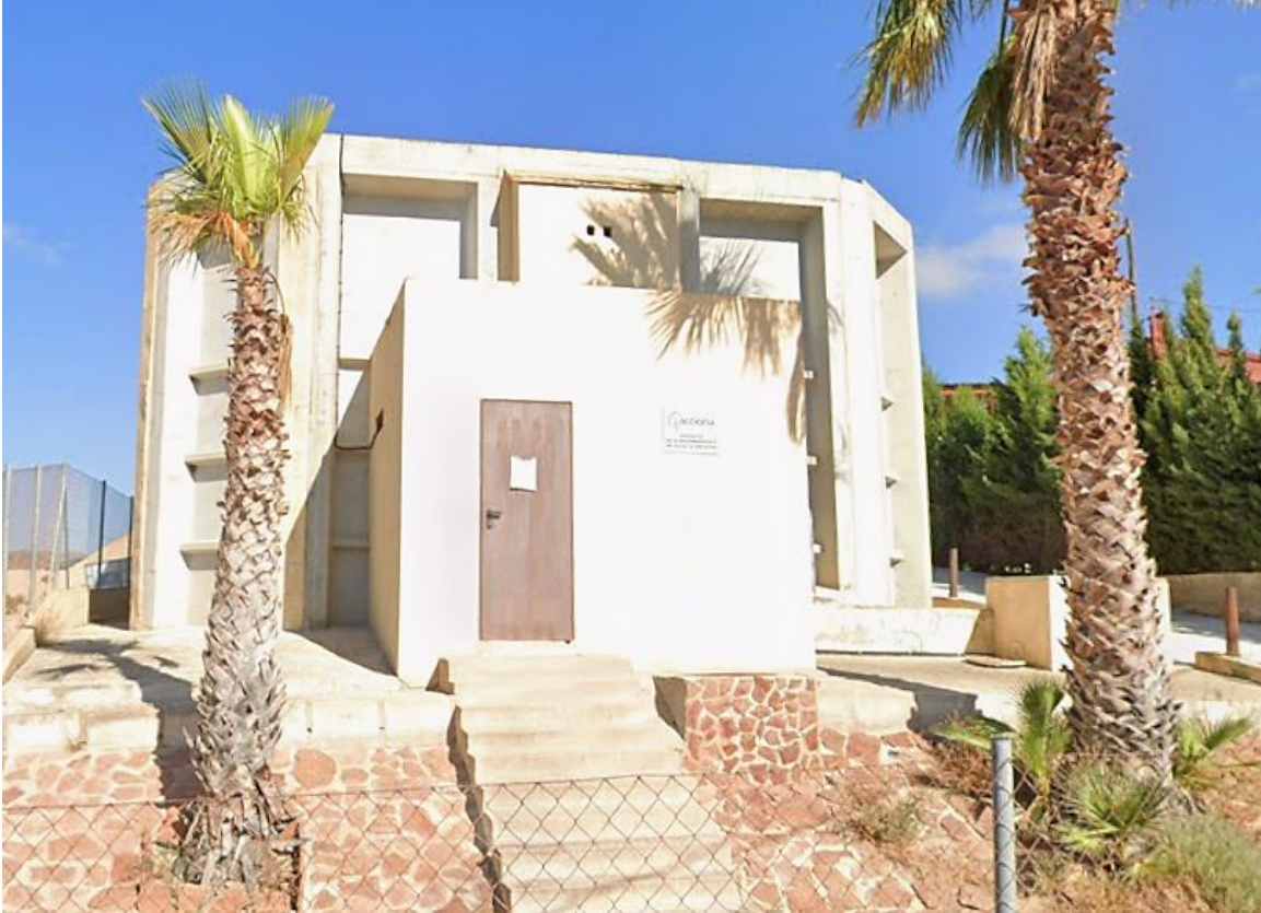
Figura 3. Depósito La Anchosa (Lorquí)
